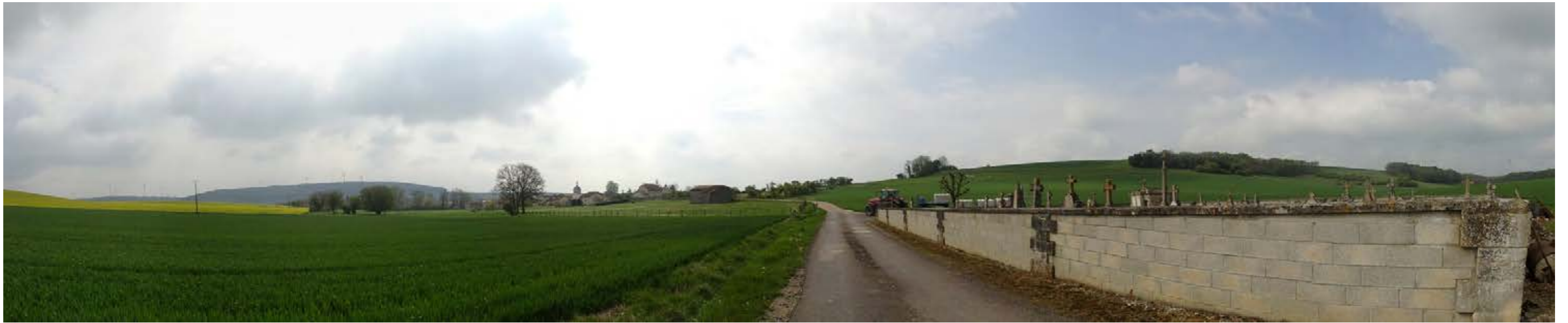
Photo 44 : En entrée de bourg d'Ambonville depuis la RD 117, la ZIP prend place sur la gauche en arrière-plan et entre en concurrence visuelle avec la silhouette de bourg d'Ambonville bien que le parc éolien de Mont Gimont qui se dessine sur la ligne de crête atténue la sensibilité (© Agence couasnon)
